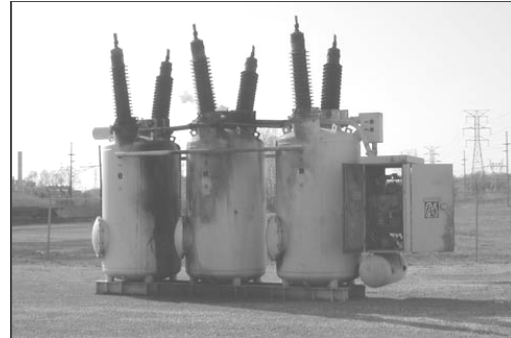
بریکرها به هنگام از کار افتادن ارستر شدت آسیب دیده اند.
